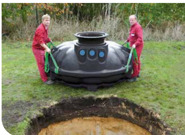
Einbaubeispiel: Flachtank NEO 3.000 Liter
