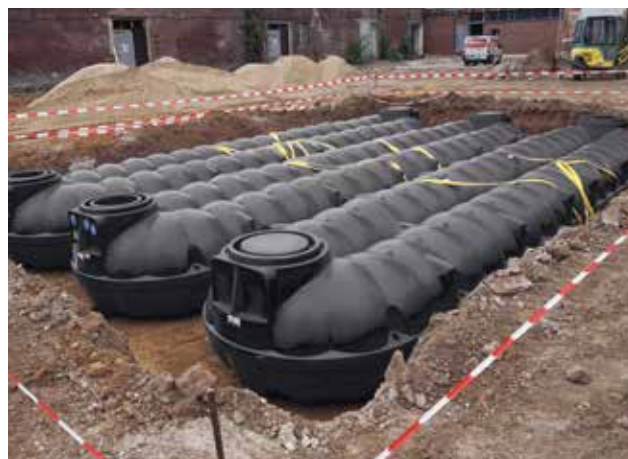
Einbaubeispiel: Großanlage Flachtank NEO 3 x 20.000 Liter
